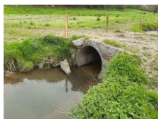
Figure 3 : Remplacement d'une buse – avant -
