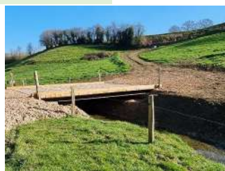
Figure 4 : Remplacement d'une buse – après -
